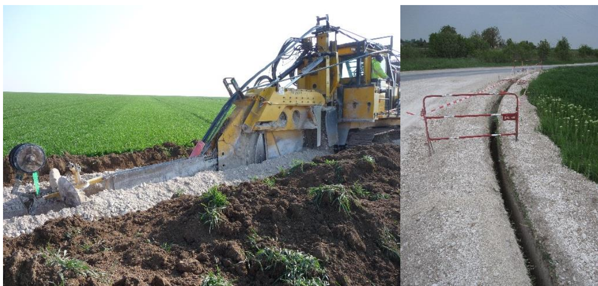
Figure 2 : Exemple de tranchée réalisée (Source : TotalEnergies)
